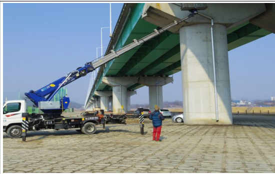
고소차를 이용한 외관조사
