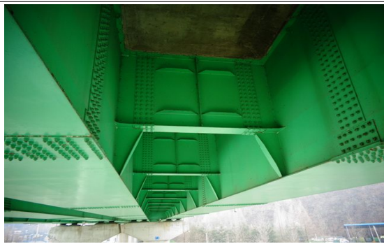
바닥판하면 및 거더 외부 전경
